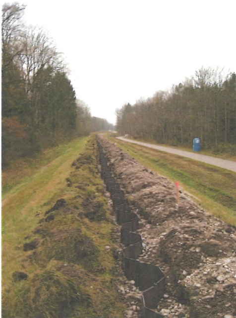
eingebaute Spundwand
