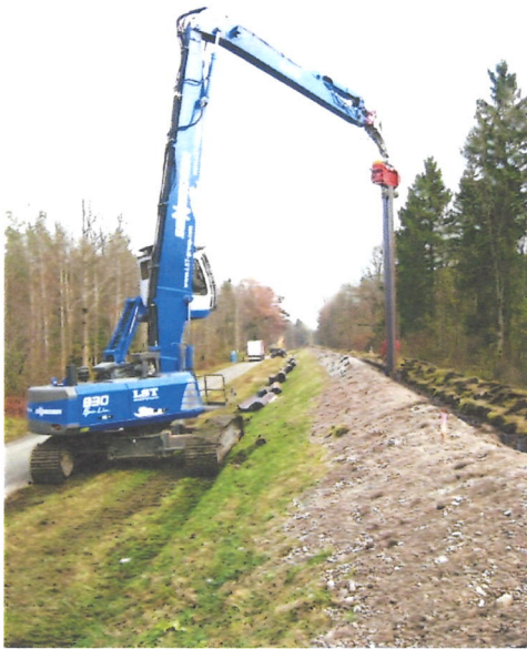
Deichsanierung bei Oberhummel
