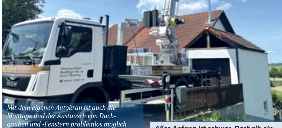
Nicht nur neue Dachstühle, sondern auch Dachsanierungen gehören zum »Alltag« der Zimmerei Mäuer
